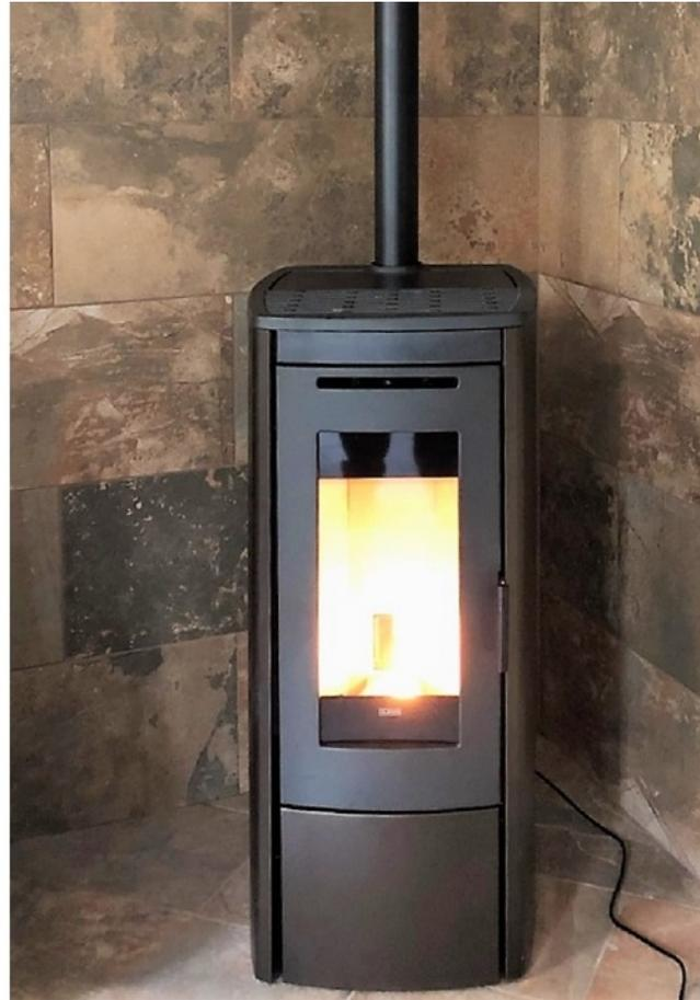
*Installation d'un poêle à granulé de bois de marque Klover modèle Soft 80 avec sortie fumées par le dessus.*
