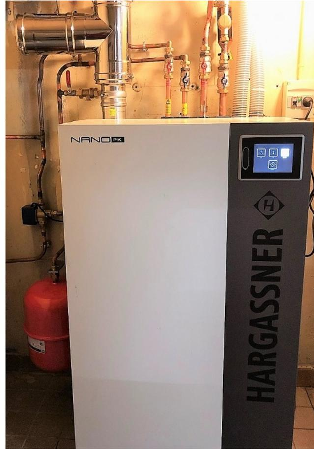
*Installation d'une chaudière granulés de bois pellets Nano 15 kw avec Silo GWTS Max -200 X 250 d'une capacité 4,4 à 6T avec remplissage déporté d'une longueur de 7 M. Pose et fourniture d'un ballon sanitaire de 300 L. simple échangeur avec résistance électrique*
