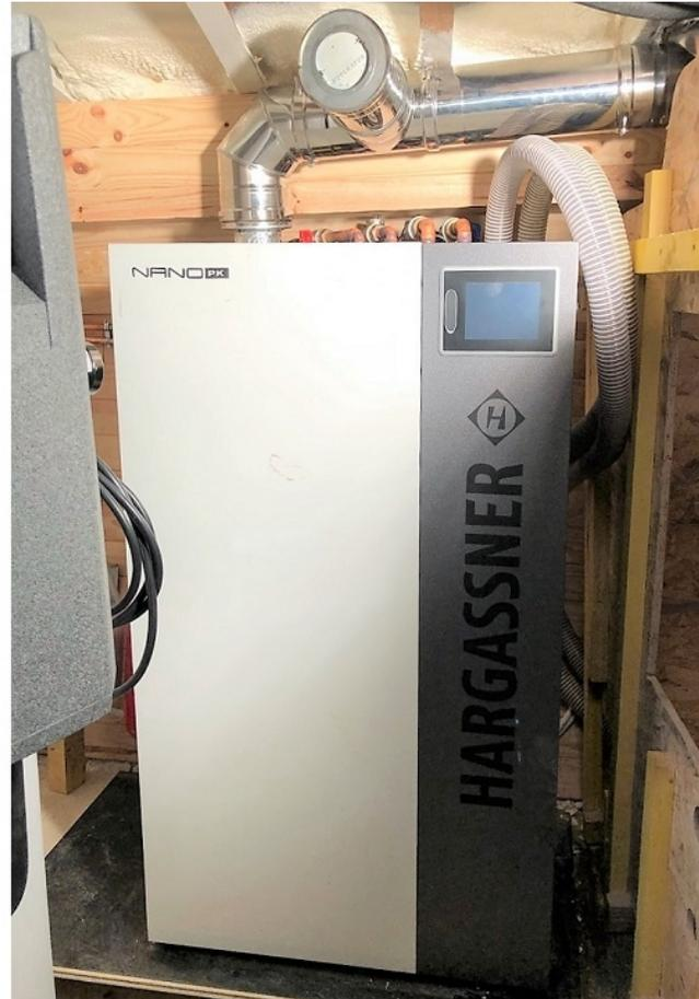
*Installation d'une chaudière granulés de bois pellets Nano 12 kw dans une péniche sur les bords de MarnePose et fourniture d'un ballon solaire de 300 L double échangeurs avec résistance électrique*
