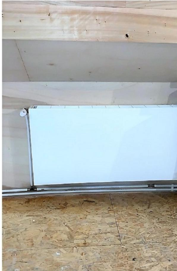
*Installation dans une péniche d'un réseau de chauffage central et pose de radiateurs. Mise en eau purge et mise en fonctionnement de l'installation Daniel Peux tu regarder je n'arrive pas à saisir l'eco conseil Circuit de chauffage central et radiateurs. Peux tu également ajouter Finimétal comme fabricant*
