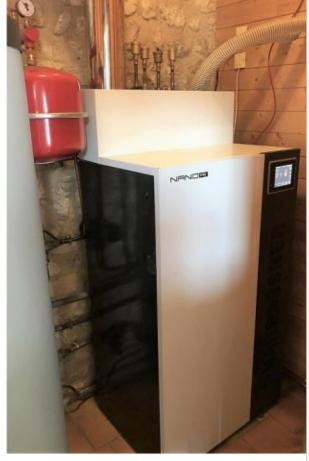
Installation d'une chaudière granulés de bois pellets Nano 12 kw avec Silos textile GWTS Max 200 X 200 d'une capacité de 5T .Pose et fourniture d'un ballon sanitaire de 300 L.
