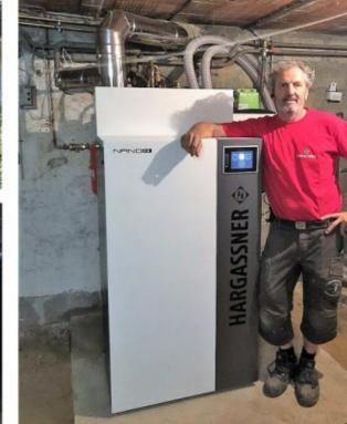
Installation d'une chaudière granulés de bois pellets Nano 9 kw avec Silos textile GWTS 200 X 200 d'une capacité de 3,8 T .Pose et fourniture d'un ballon sanitaire de 200 L.
