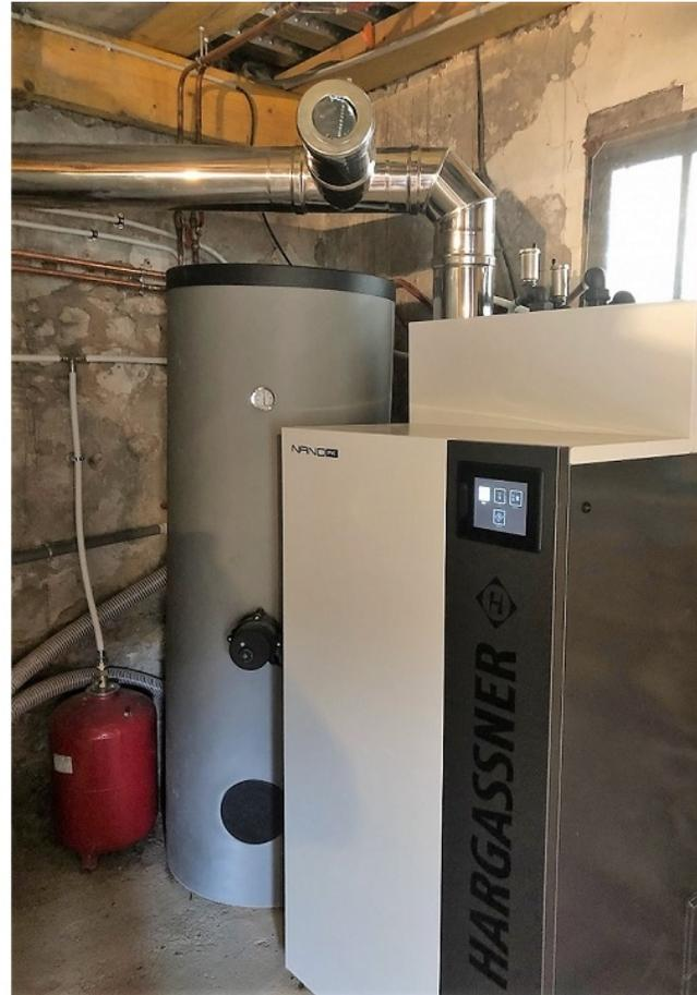
*Installation d'une chaudière granulés de bois pellets Nano 15 kw avec SiloGWTS Max 250 X 200 d'une capacité 4,4 à 6 T Pose et fourniture d'un préparateur de 300 L simple échangeur avec résistance électrique*
