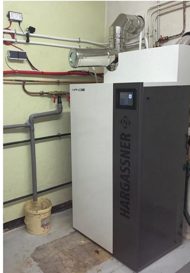
*Installation d'une chaudière granulés de bois pellets Nano 15 kw avec SiloGWTS Max 160 X 250 d'une capacité 3,5 à 5 T Pose et fourniture d'un préparateur de 300 L simple échangeur avec résistance électrique*
