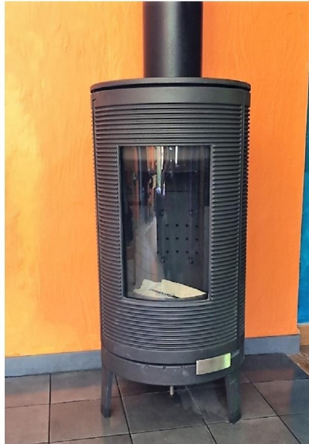
*Entreprise RGE QualiBois installateur de poêle à bois près de Corbeil-Essonnes Installation d'un poêle à bois bûches fonte de Marque Invicta modèle Okino d'une puissance nominal de 7 KW . Conduit de accordement en Acier noir et conduit de fumées en flexible double peau.*
