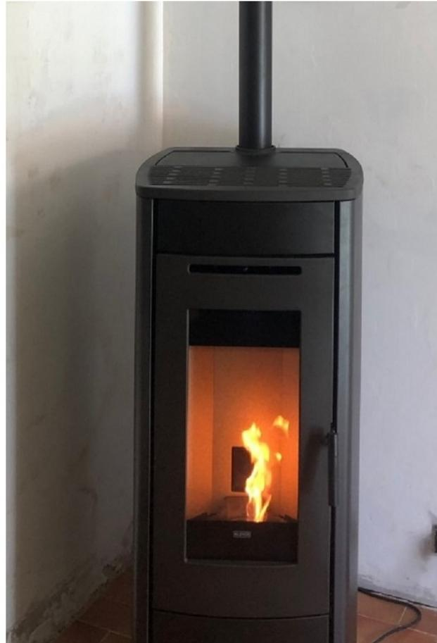
*Installation d'un poêle à granulé de bois de marque Klover modèle Soft 100 avec sortie fumées par le dessus.*
